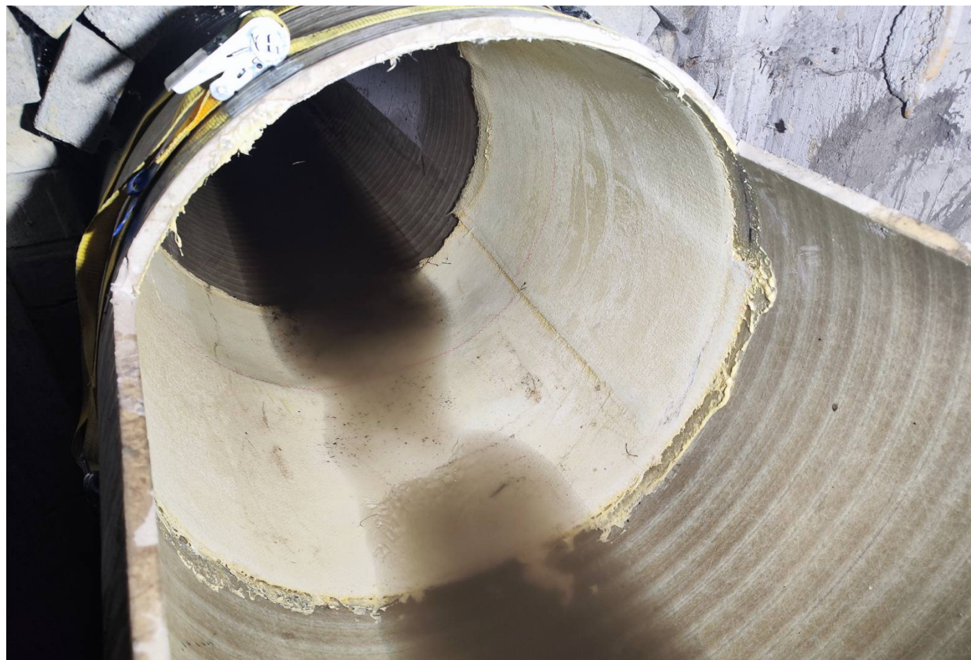
CIPP (Cured-in-place pipe) локална рехабилитация
